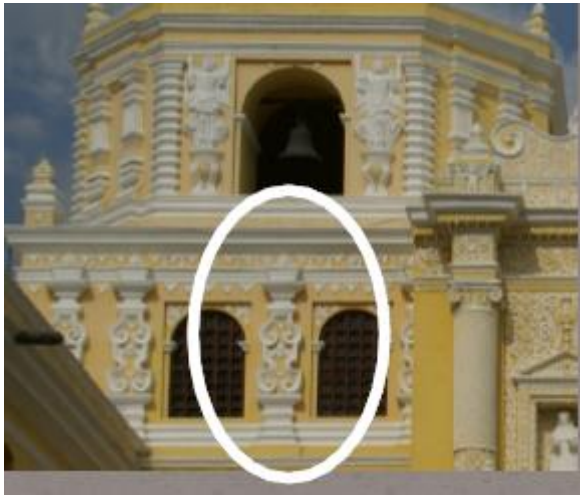
TORRE DEL CAMPANARIO DE LA IGLESIA DE LA MERCED EN ANTIGUA GUATEMALA Con una variante de la pilastra serliana
